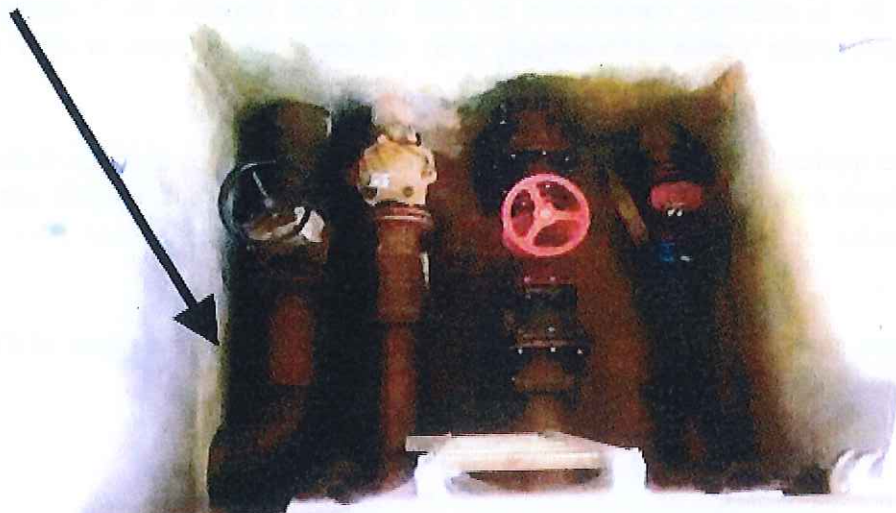
Figure 6 : Piquage sur canalisation d'équilibre des 2 b"ches semi-enterr"es
