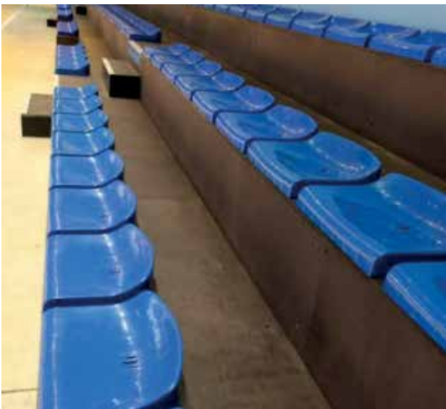
Rénovation des gradins du gymnase FIORANI
