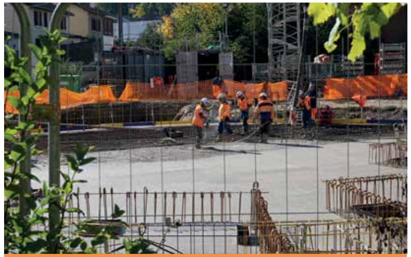
Bassin de pollution
